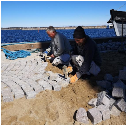
Brolæggerne er i gang med chaussesten i bueforbåndt.
