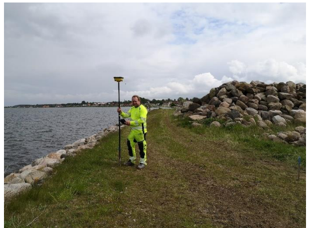
Afsætning af stien pågår
