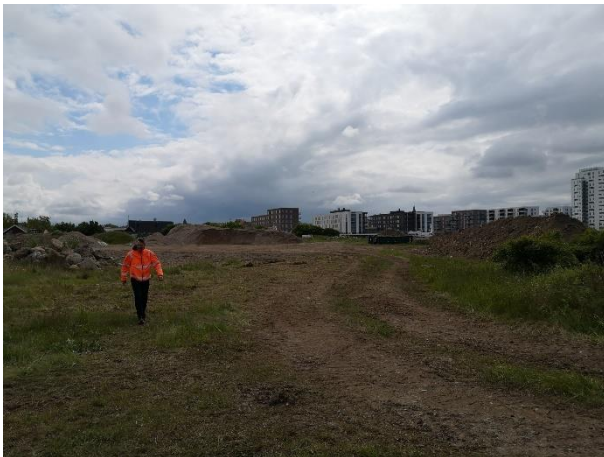
Oprydningen på deponiet er igangsat
